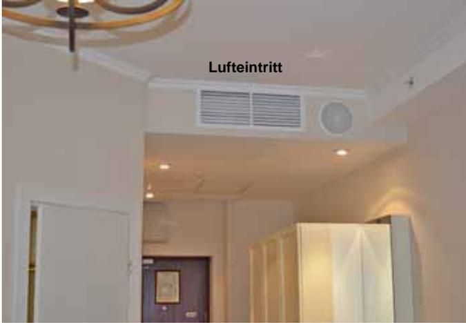
**Klimakonvektor IO ...** für Heizen und Kühlen, mit Primärluftanschluss, eingebaut in die Zwischendecke z. B. im Vorraum, für kontrollierten Luftwechsel und Klimatisierung des Hotelzimmers / Hotelappartementes.
